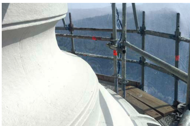
Abdichtung denkmalgeschützter Gebäude
